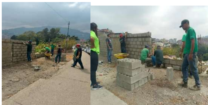
Gráficas 11 y 12: Inicio construcción Muro Perimetral, Av. Las Minas.
